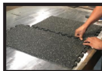
6. Proceda a unir las piezas entre sí, mediante su sistema de "interlocking".
